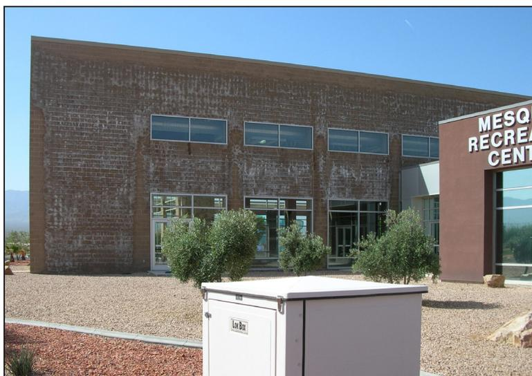
Figura 4. Ejemplo de natatorio sin barrera de vapor, que exhibe una pulverización blanca en el exterior del edificio
