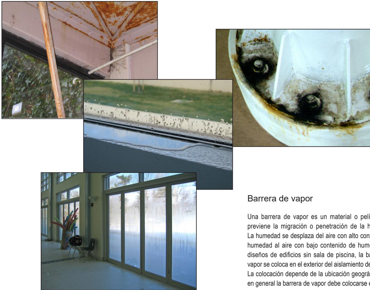
Figura 3. Ejemplos de condensación y de distribución deficiente del aire
