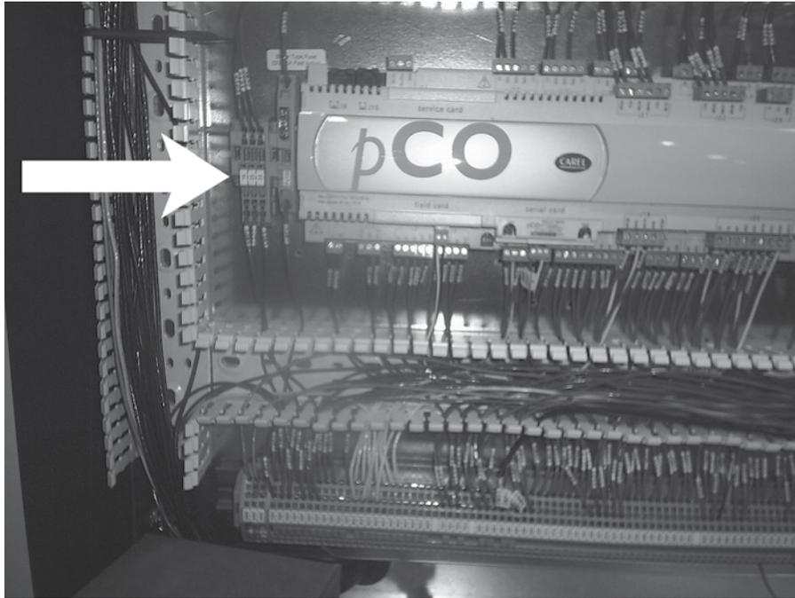
Figura 23- Los interruptores de control de motores están en los bloques de terminales de desconectores con desconector tipo cuchilla. Estos son los bloques de terminales, delgados de color gris, con una tapa color naranja que puede abrirse girándola.
